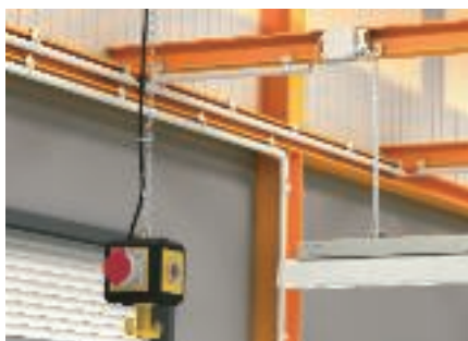
Кріплення кабелю на звисаючому ланцюгу
