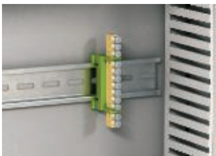
Використання клеми захисного проводу
