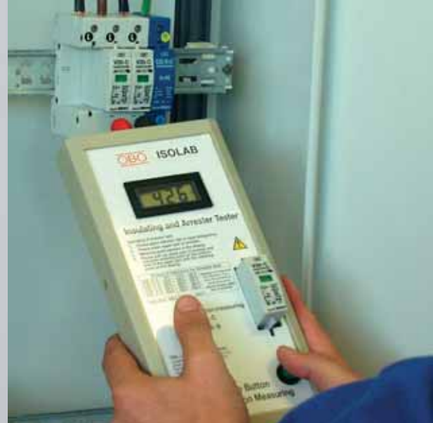
Aşırı gerilim deşarj düzenekleri ölçülürken
