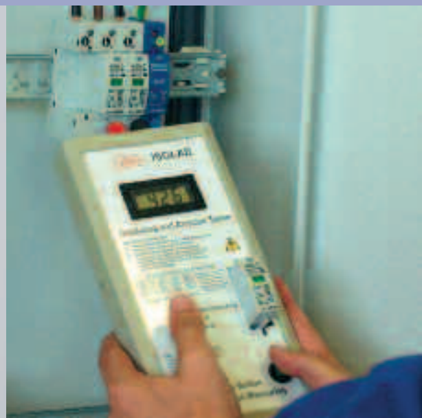
Merjenje prenapetostnih odvodnikov
