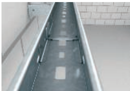
Legătură longitudinală pentru jgheab pentru susținerea corpurilor de iluminat
