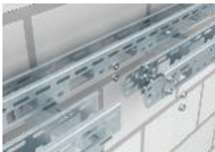
Legătură longitudinală pentru șină pentru susținerea corpurilor de iluminat
