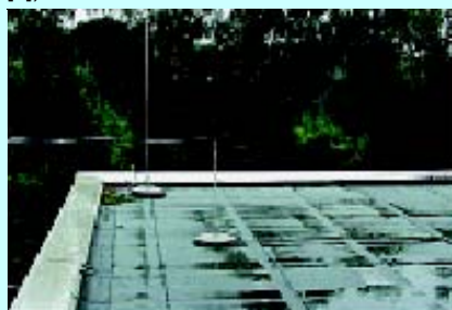
Figura 4: Colocação segura da linha adutora
