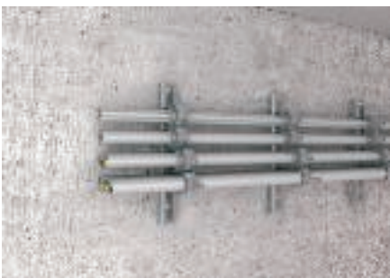
Zamontowane obejmy U na ścianie z pojedynczym, podwójnym i potrójnym obciążeniem.
