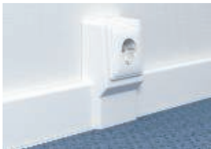
Montering overdel apparattholder Ferdig monterte enhetsholder.
