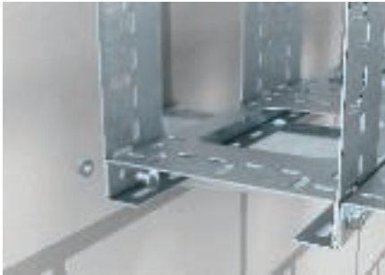
Montage van het bodemprofiel in het BKK-systeem.
