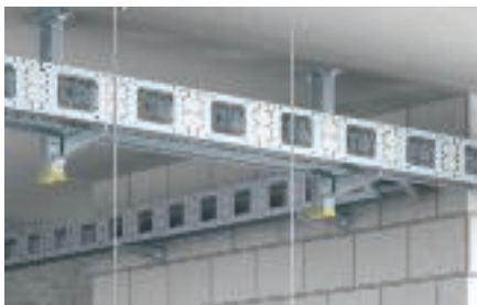
Montage van het BKK-systeem met IS 8-profielen aan het plafond.
