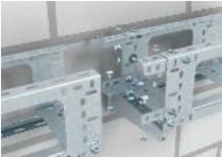
Koppeling met verbinders bij BKK-systeem met het type SSV.
