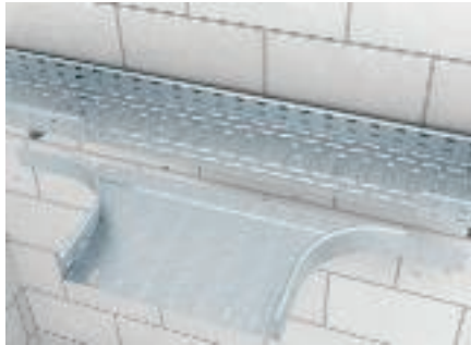
Montage Anbau-Abzweigstück (Breite 400 - 600 mm)
