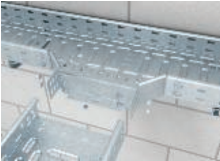
Montage Anbau-Abzweigstück (Breite 100 - 300 mm)
