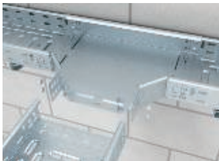
Montage T-Abzweigstück (Breite 100 - 300 mm)
