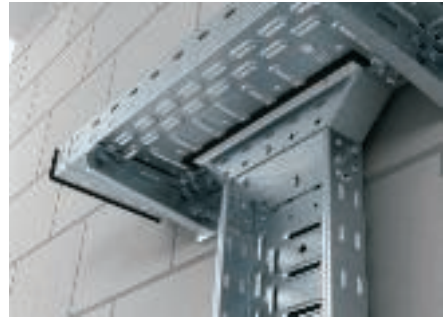
Montage Anbau-Abzweigstück vertikal (Ansicht unten)
