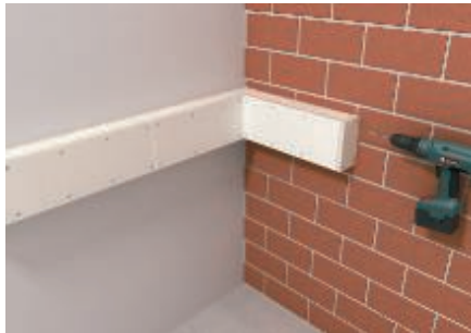
Montage eines Endstücks, hergestellt aus einem Kanaldeckel, auf das Kanalende.
