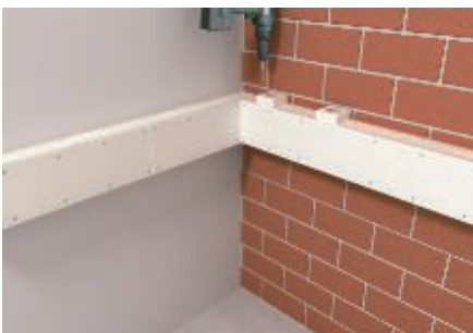
Aus dem Kanaldeckel ein passendes Endstück herstellen. Endstück mit Dichtungstreifen versehen und an das Kanalende verschrauben.
