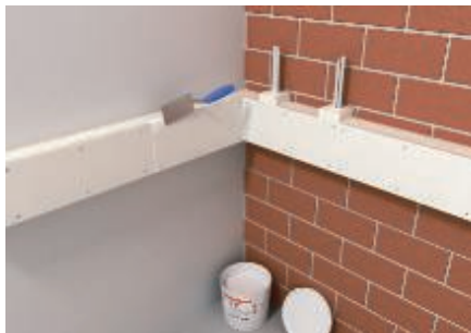
Ausgebrochene Kanal- und Deckelstücke werden mit dem BSK-Mörtel wieder verspachtelt.
