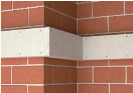
Montage eines Innen- und Außenecks an einem Mauerversprung.
