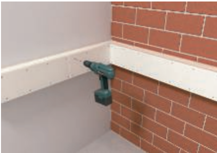
Zweiten Kanaldeckel auf die Kanalwanne schrauben.
