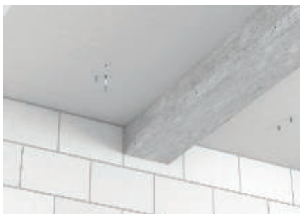
Montieren der Bolzenanker FAZ II zur Befestigung der U-Hängestiele.
