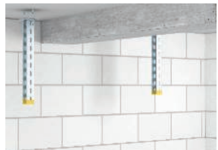
Verschrauben der U-Hängestiele an den Bolzenankern.
