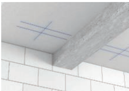
Anzeichnen der genauen Lage der Bohrlöcher für die U-Hängestiele im Abstand von max. 1 m.
