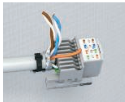
Prietaiso prijungimas - laidų rūšiavimas Atskiras gyslas nutieskite ir užfiksuokite
