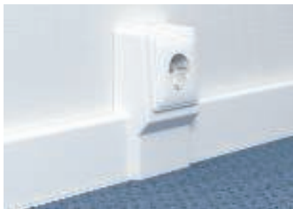
Montaža poklopca nosača Montirani nosači.
