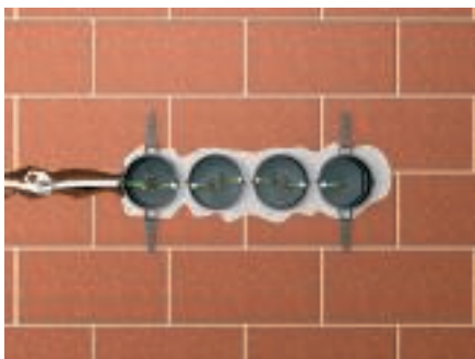
Installation de boîtes d'encastrement
