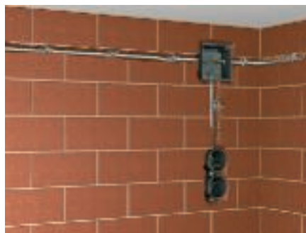
Installation de boîtes de dérivation
