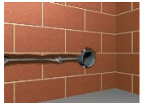
Installation d'une boîte d'encastrement
