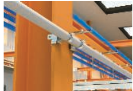
Montage des pinces de fixation type TKCU
