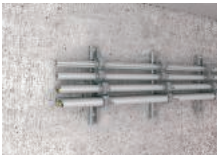
Brides de fixation BBS montées sur le mur avec câbles uni et/ou multifilaire et faisceau de câbles.
