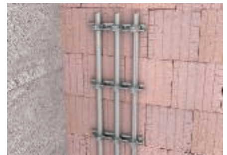
Brides de fixation BBS montées à la verticale sur le mur avec câbles uni et/ou multifilaire et faisceau de câbles.
