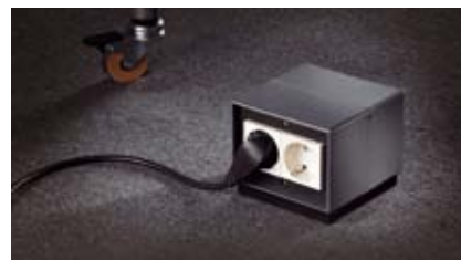
Lattian päälle asennettu lattiarasia.
