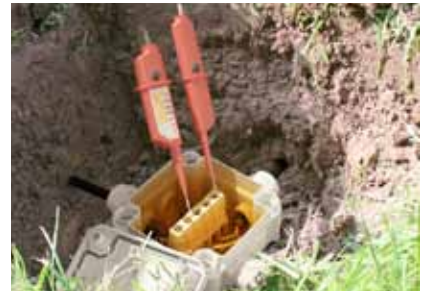
Aquasit on isesulguv, nii et elektriühendusi saab pärast paigaldust lihtsalt viisil kontrollida.
