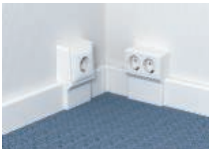
Afsluttet montering Stikdåserne kan placeres lige der, hvor der er brug for dem.
