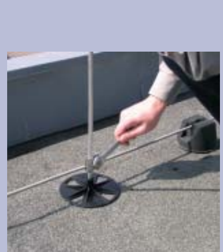
Schellenmontage im Unterteil mittels Stecktechnik
