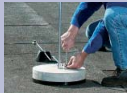
Keine zusätzliche Montage einer Rundleiterklemme nötig. Rundleiter einfach an der Klemme montieren.
