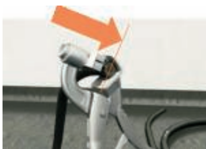
5. Kabel podélně nařízněte na protilehlých stranách
