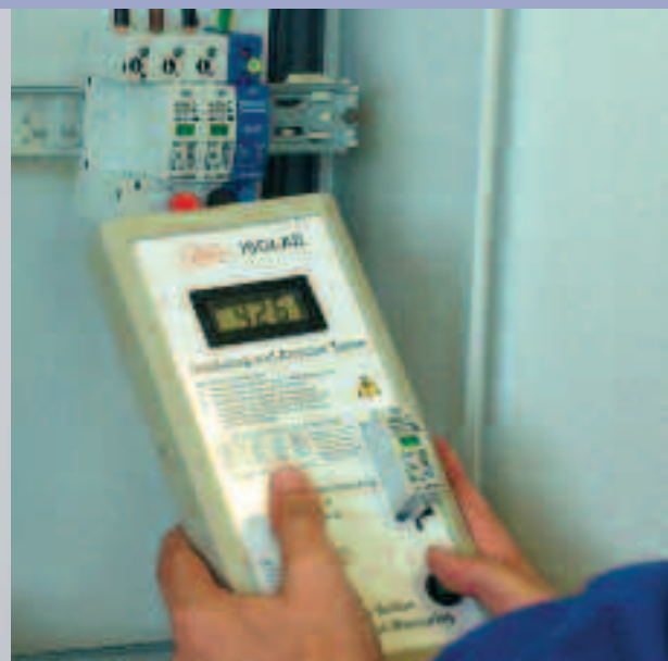
Měření svodičů přepětí
