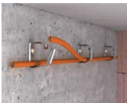
Instalace kabelů do držáku Vkládání kabelů do skupinového držáku 2031/M.
