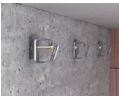
Upevnění skupinových držáků Fixace skupinových držáků 2031/M na stěnu pomocí ocelové hmoždinky.
