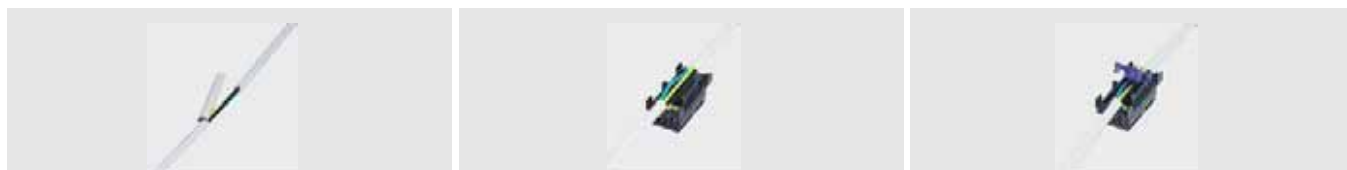
Стъпка 1: Отстраняване на изолацията на кръглия кабел 3 x 2,5 mm 2 на произволно място до дължина 50-55 mm.
