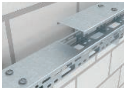
Закрепване на капака
