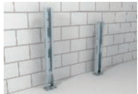
Монтаж на колона за захранване на електродвигател с крак на колоната
