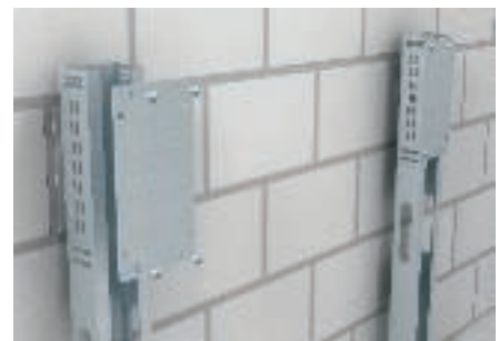
Монтаж на панела за уреди
